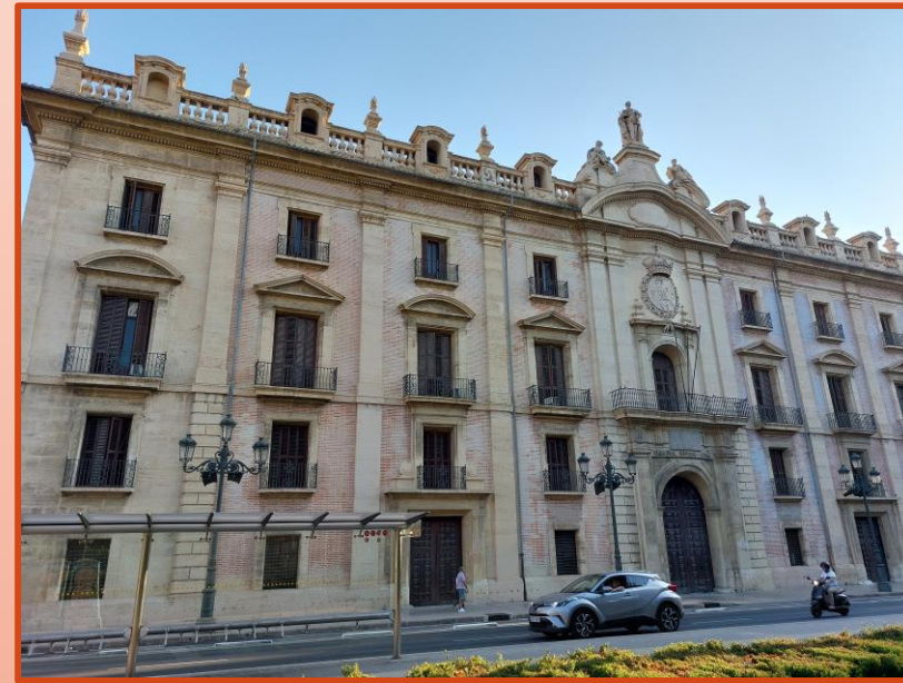
Sede oficial del TSJCV, en rehabilitación
